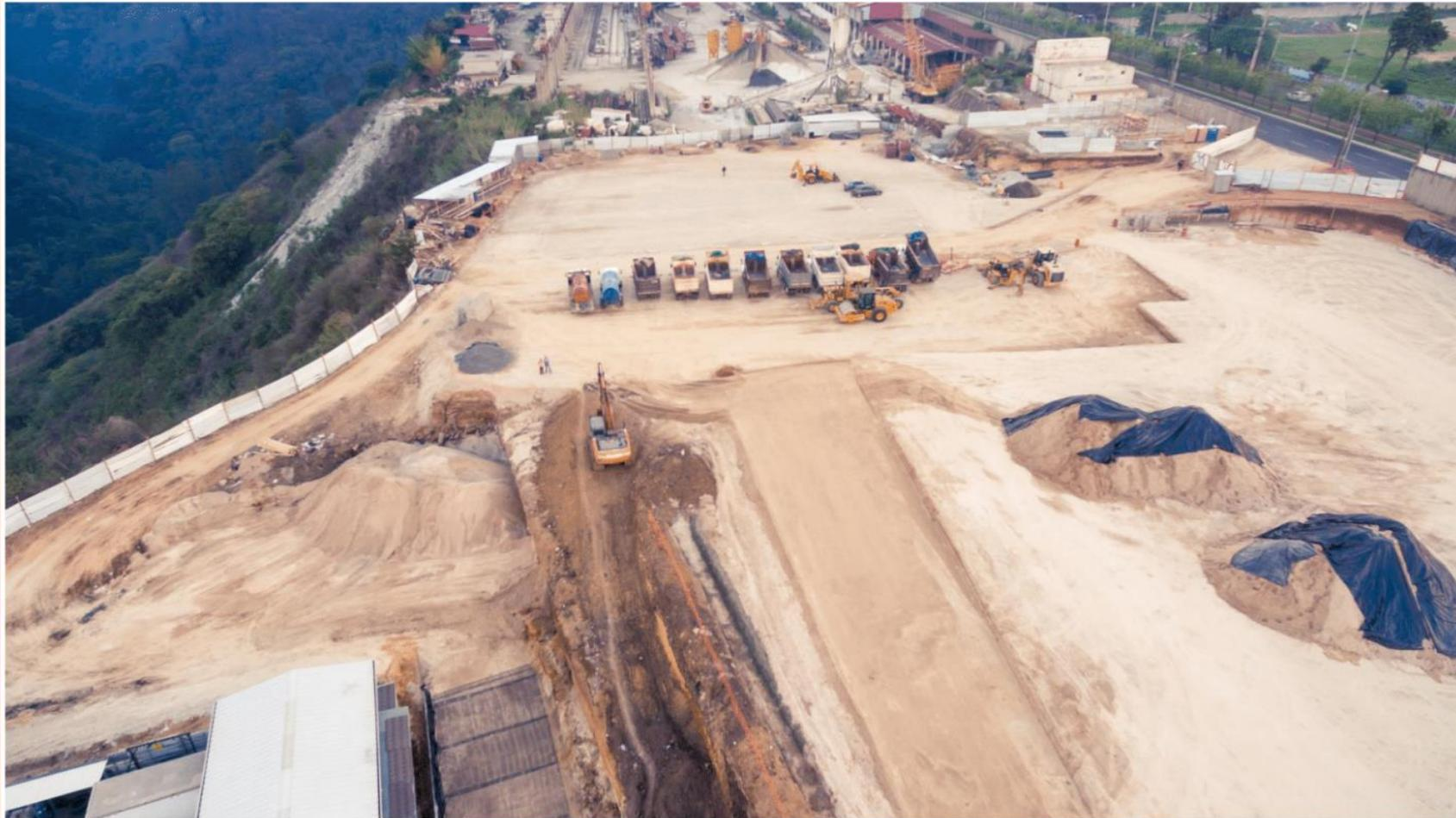
Fase de movimiento de tierra e instalación de geomalla TenCate Mirafi 7XT y 10XT
