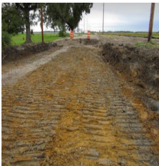
(imagen 1 ) Preparación de la subrasante
