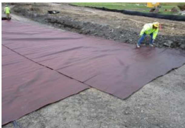
imagen 2 Implementación de geosintéticos
