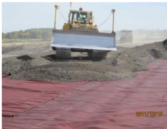
Imagen 4 Expansión de agregado sobre el geosintético
