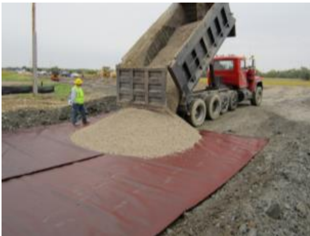
Imagen 3 Colocación de material de préstamo en suelos blandos
