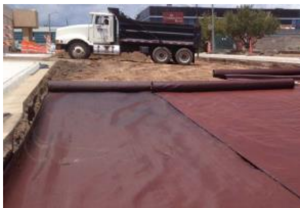
Imagen 7 Extendiendo el geosintético de refuerzo a una superficie vertical
