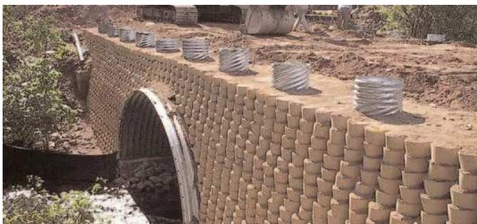
*Forro de confinamiento con Geoceldas apilado*
