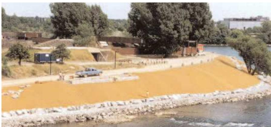
*Producto Laminado de control de erosión (RECP: Rolled-Erosion Control Product)*
