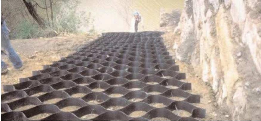
*Estabilización con Geoceldas de confinamiento*
