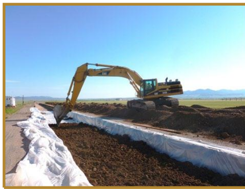
Figura 1: Llenado de la zanja con subrasante.
